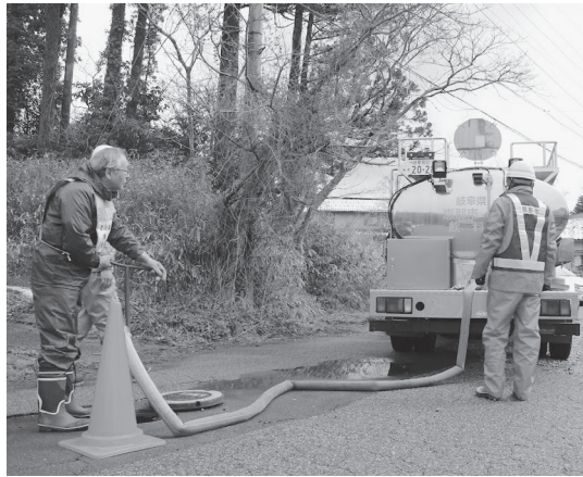
給水車への水の補給作業をする自治労のボランティア支援参加者
